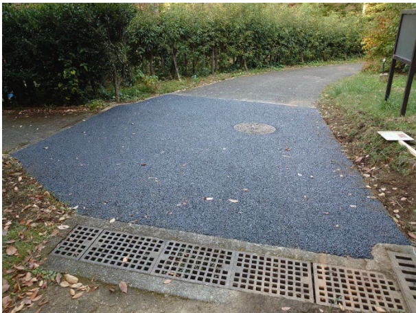
貝取山緑地で園路舗装工事を担当しました（令和4年度）
