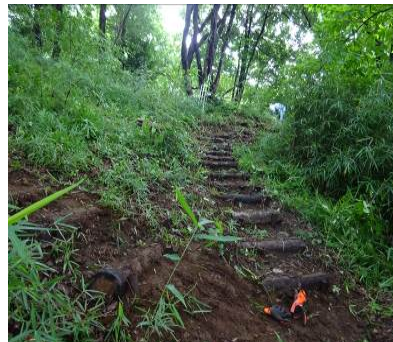
里山林作業路設置
